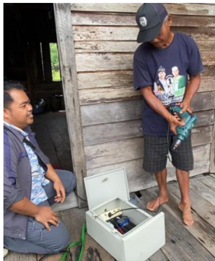
Gambar 7. Demonstrasi menghidupkan bor listrik menggunakan system PLTS
