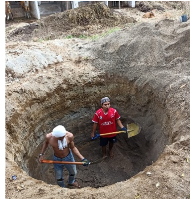
Gambar 1 Rancangan dan proses pembuatan digester tipe fixed dome
